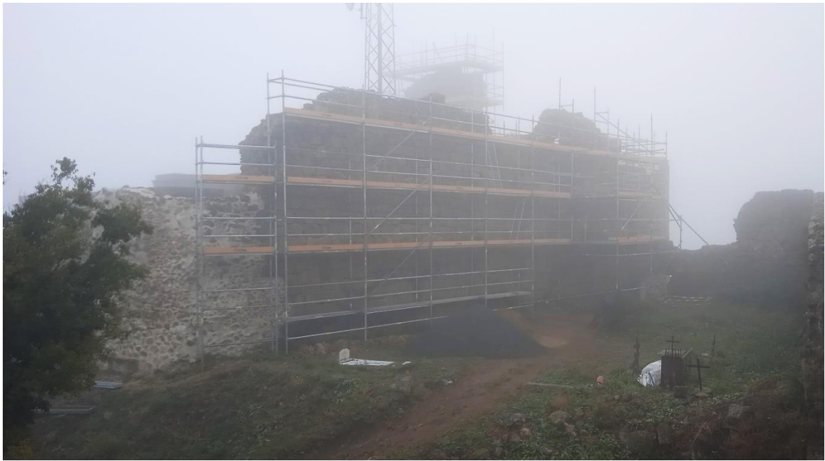
Andamiaje de restauración (muro monumental)
