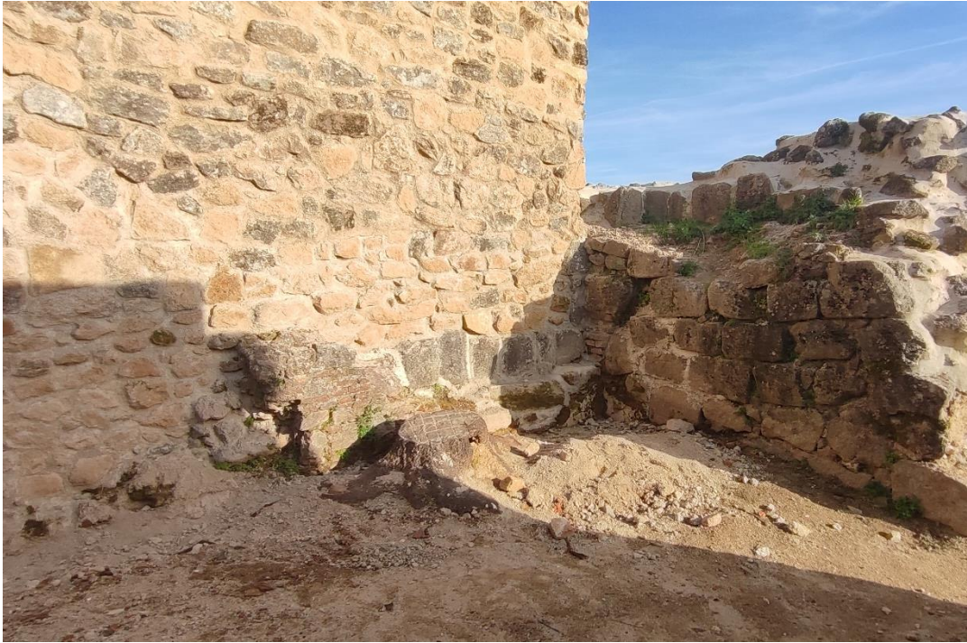
Muro monumental del alcázar restaurado junto con restos de ladrillo
