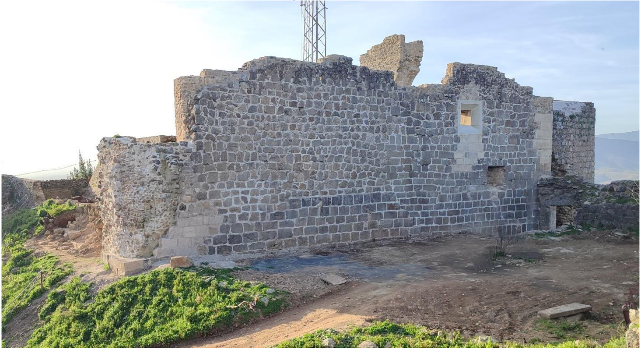
Rejuntado de la sillería y ventanal
