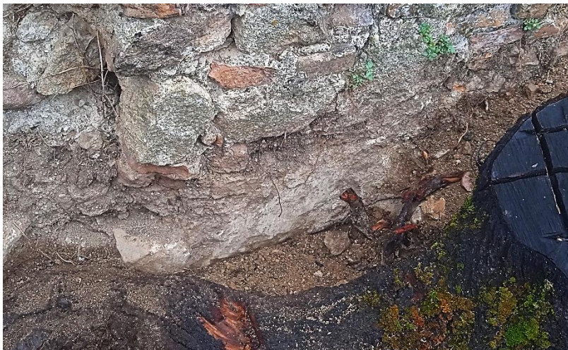
Restos del enlucido en superficie. Remataba el arranque de un soporte en ladrillo
