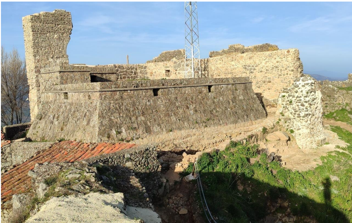
Restauración de muros monumentales en el área del alcázar
